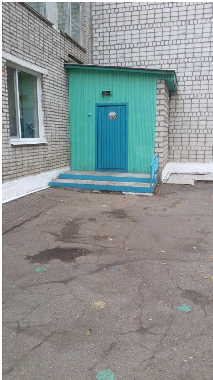
Фото № 3 «Эвакуационный выход группы №1»
