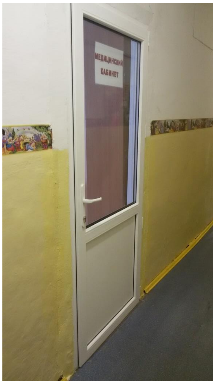
Фото № 9 «Дверь в коридоре 1 этажа»
